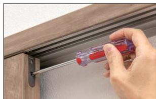
上下方向の調整(上約3mm、下約2mm)
